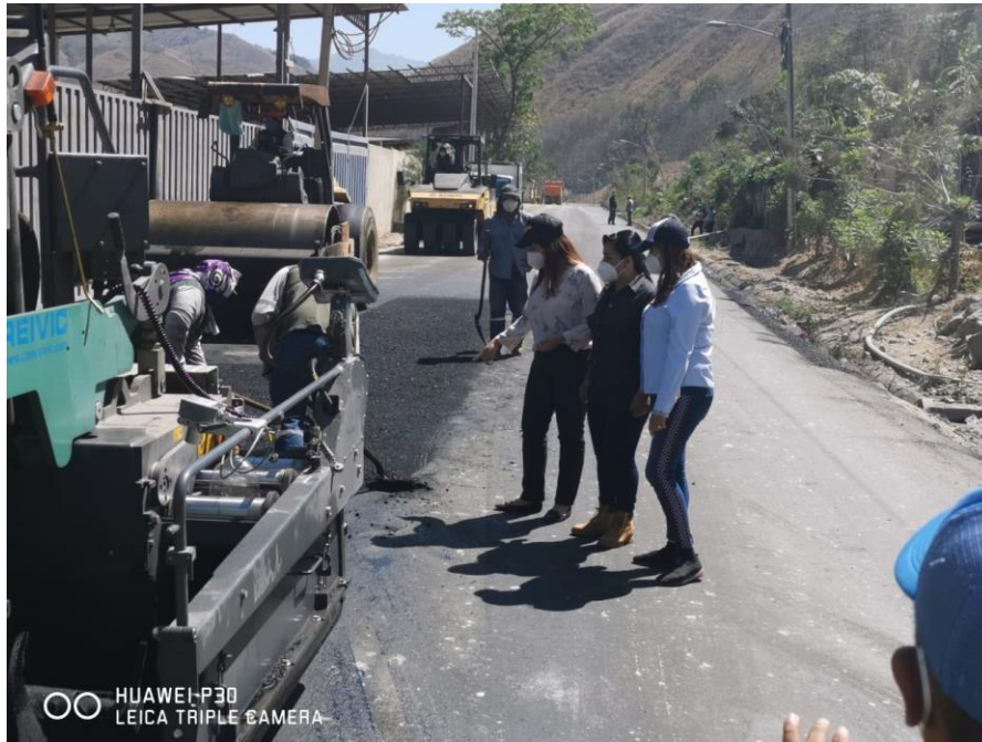
Ilustración 5. Fiscalización de colocación de carpeta asfáltica-Via el Pindo.
