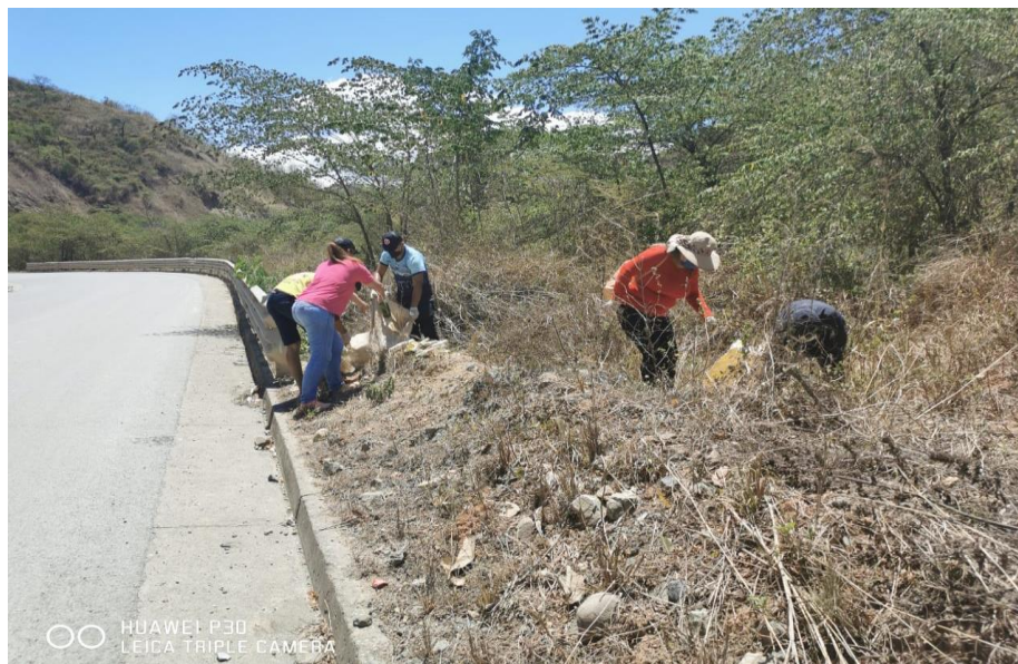
Ilustración 6. Minga de limpieza en vía a salati.
