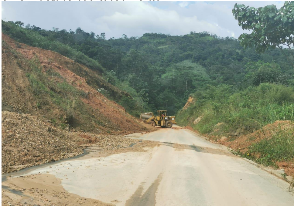
Ilustración 14. Limpieza de acceso vial.
